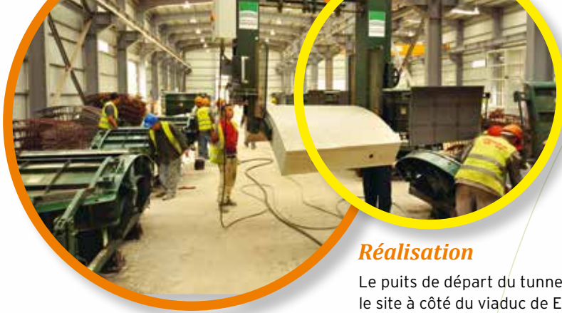
Décoffrage et démoulage d'un voussoir
