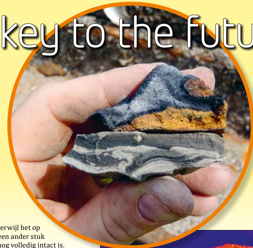
03. Twee corrosiekorsten van verschillende dieptes langs een diepe damwand, uitgetrokken in de Amazonehaven op de Maasvlakte.
